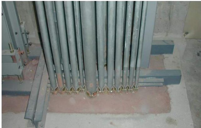
รูปที่ 2.9 ตัวอย่างการอุดพื้นเพื่อป้องกันไฟลุกลาม
