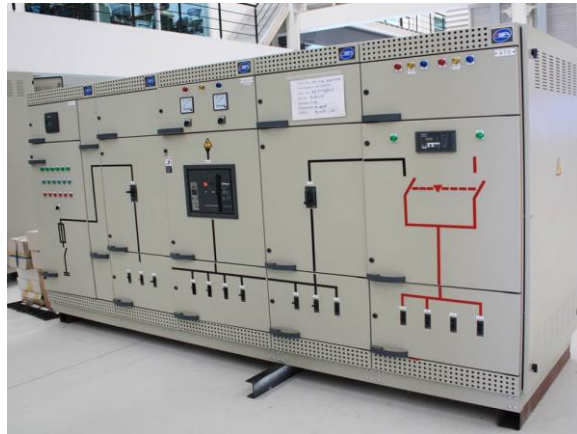
รูปที่ 2.18 ตัวอย่างแผงเมนสวิตช์ขนาดเล็กและใหญ่
