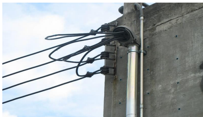
รูปที่ 2.3 การใช้หัวงูเห่าเพื่อป้องกันน้ำเข้าท่อ
