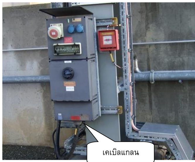
รูปที่ 3.10 การติดตั้งใช้งานเคเบิลกลอน
