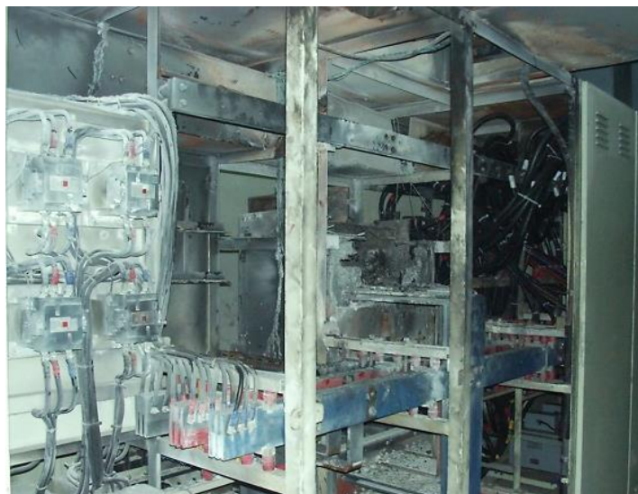
รูปที่ 1.56 ตัวอย่างความเสียหายจากการระเบิดจากอาร์ค
